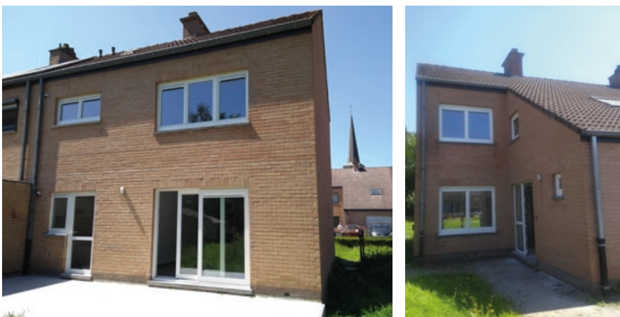
Grimbergen (Humbeek) Dr. Carlierstraat 19: vervanging houten buitenschrijnwerk door pvc
