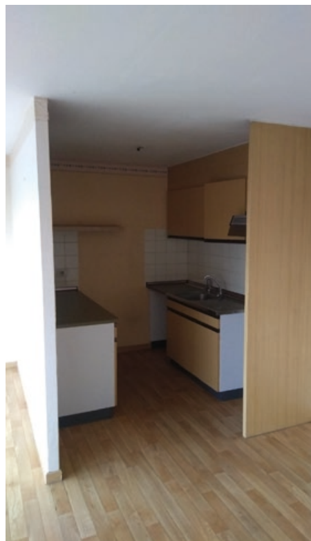
Keukenruimte voor de renovatie
