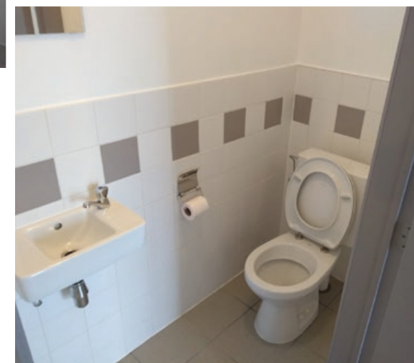
Toiletruimte na renovatie
