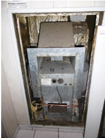
Voor de cv-reconversie: ruimte van de cv-ketel
